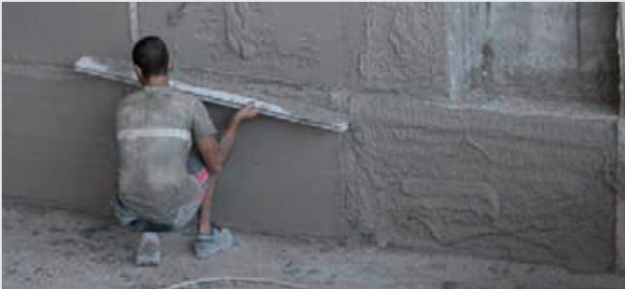
Recrecido de las paredes Levelling mortar for walls Chapes des parois
