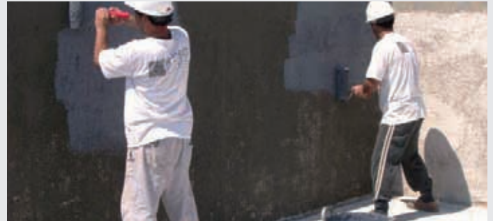
Aplicación de Hidroelastic Application of Hydroelastic Application de l'Hidroelastic
